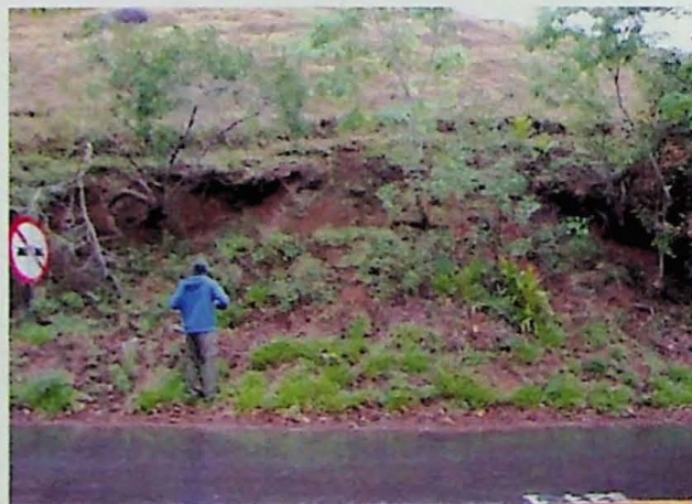
Fig. 13.2 – Talude de corte com material mobilizado (tálus).
