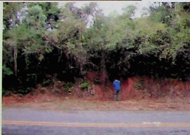
Fig. 13.1 – Talude de corte em solo areno argiloso.
