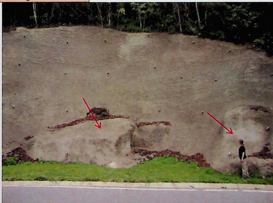
Fig. 27.1 – Talude de corte (II) com revestimento de concreto e sistema de drenagem profunda. Possíveis estruturas da rocha são indicadas.
