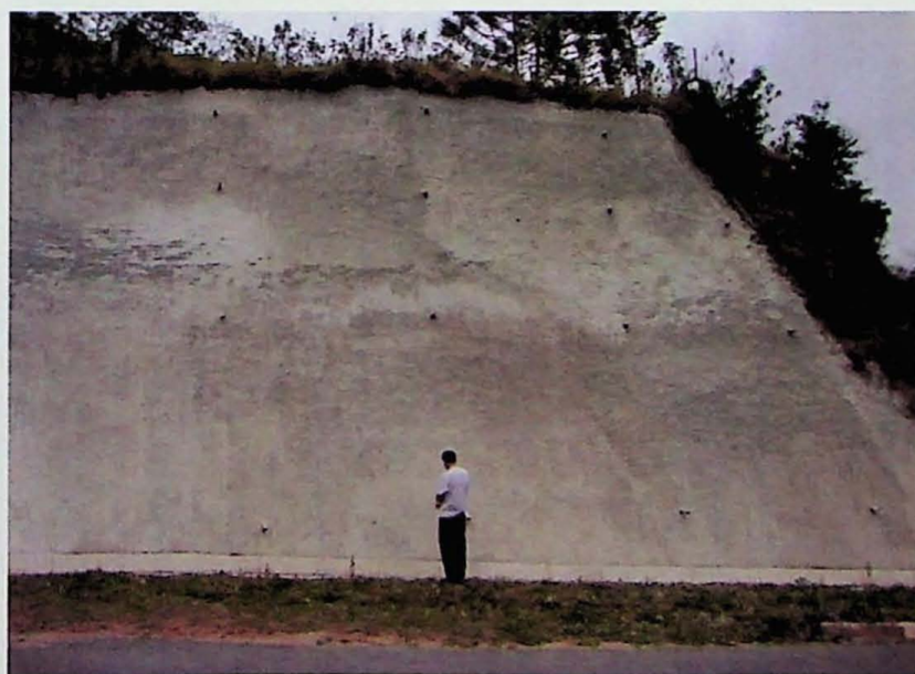
Fig. 11.1 – Talude de corte com tratamento de concreto projetado.
