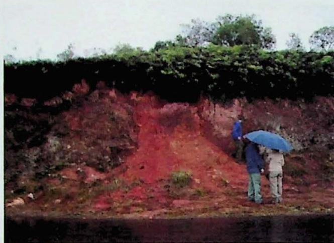
Fig. 17.2 – Feição de escorregamento raso em material arenoso, parte norte do talude.
