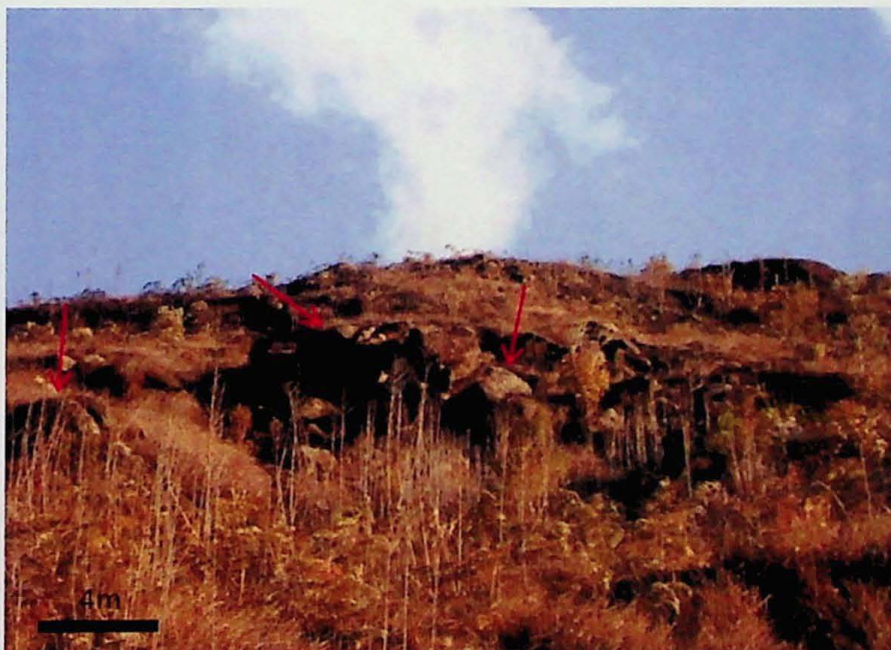
Fig. 1.1 – Talude de corte em colúvio encimado por encosta natural com blocos.
