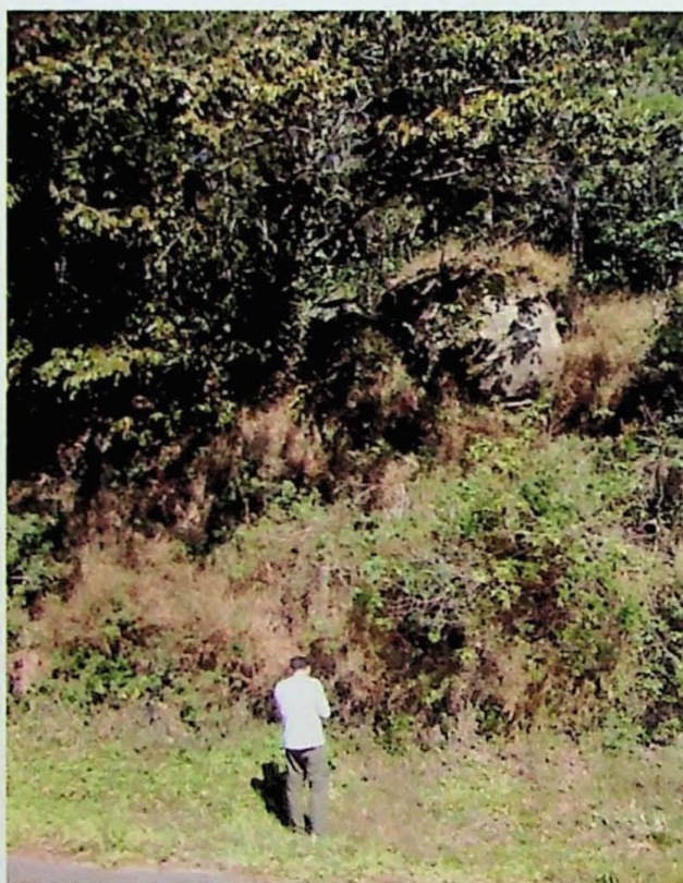
Fig. 3.3 – Bloco de aproximadamente 15 m 3 com possibilidade de instabilização
