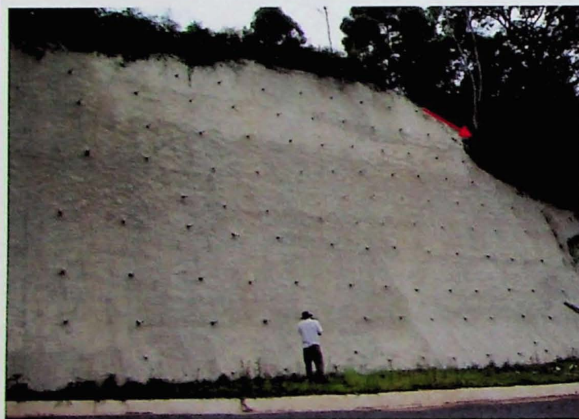
Fig. 9.2 – Talude tratado com concreto projetado e drenos. Possível observar árvores com troncos tortos na parte superior do talude.
