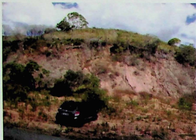
Fig. 7.1 – Vista geral do talude A, com grande volume de material mobilizado.
