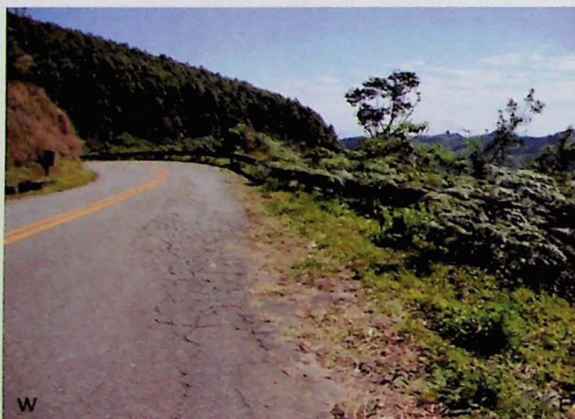
Fig. 4.3 – Detalhe do asfalto trincado e guard rail curvado.
