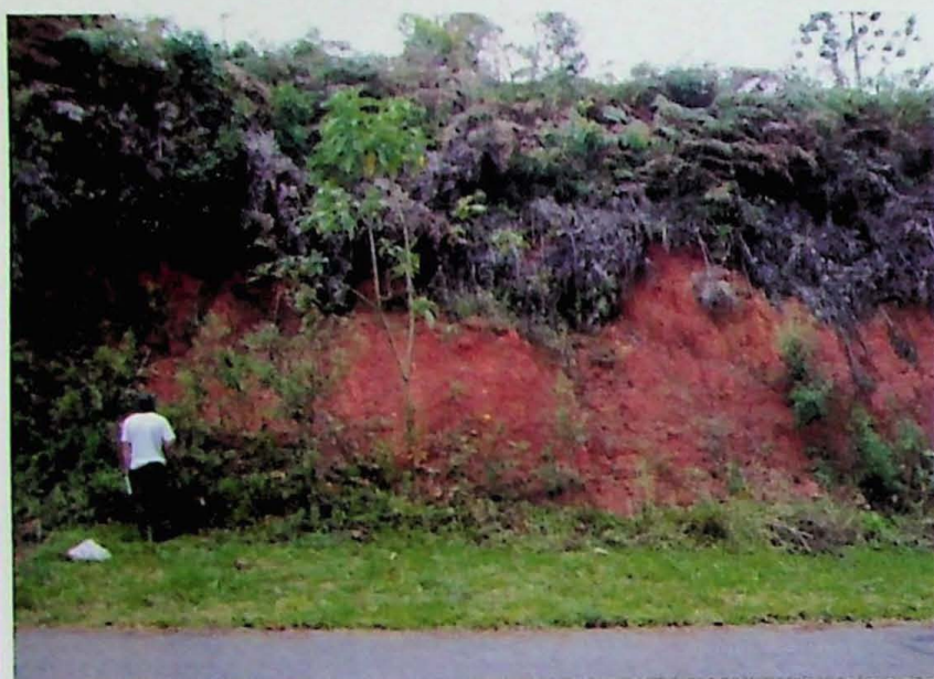
Fig. 9.1 – Talude com feição de escorregamento planar raso em solo areno siltoso.
