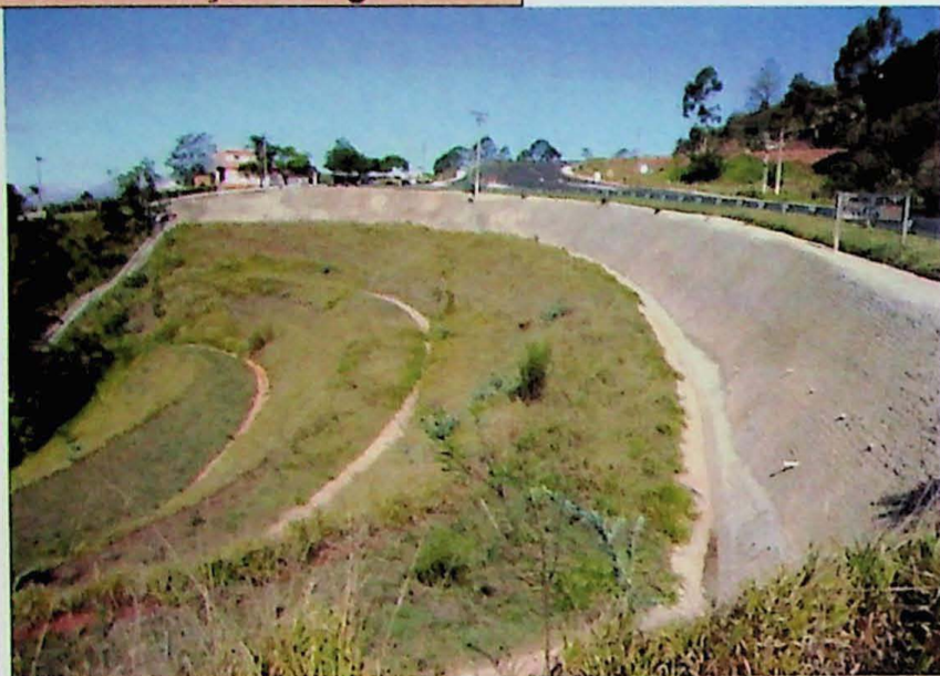
Fig. 30.1 – Talude com concreto projetado, drenagem profunda e superficial, proteção vegetal e retaludamento.
