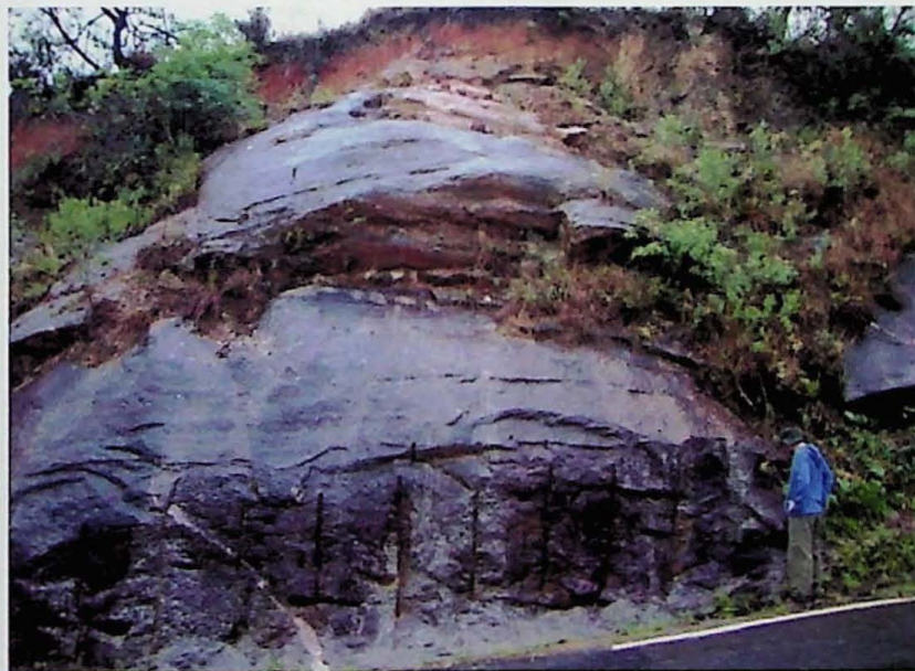
Fig. 20.1 – Vista geral do talude em rocha, com cobertura de solo no topo de aproximadamente 2m.
