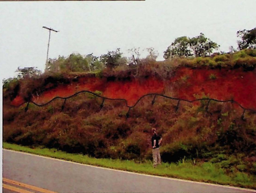
Fig. 25.1 – Vista geral do talude, com indicação do material mobilizado.
