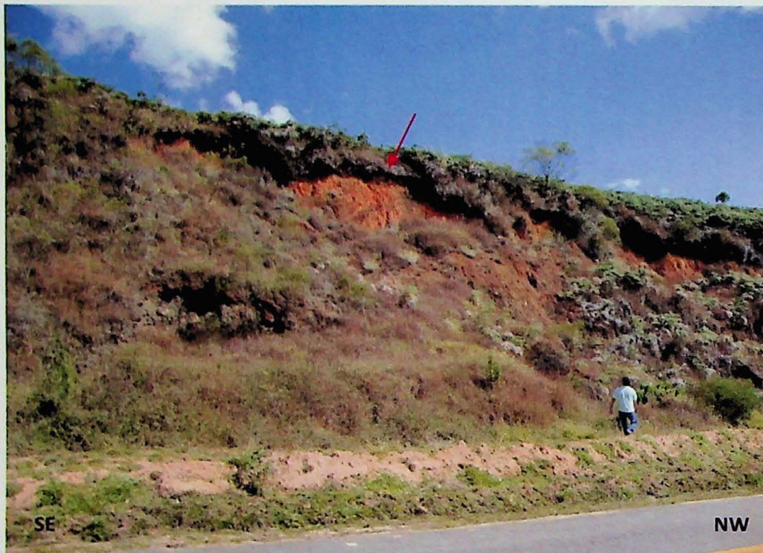
Fig. 6.1 – Vista geral do talude. Detalhe para degrau no topo da ruptura (horizonte pedológico).
