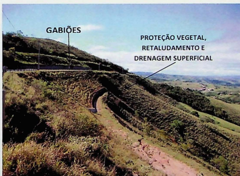
Fig. 29.2 – Vista geral dos taludes tratados, com indicação da medida estrutural adotada.
