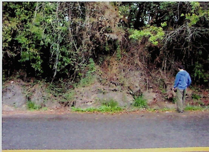
Fig. 14.1 – Talude com escorregamentos de solo entre os blocos de granito.
