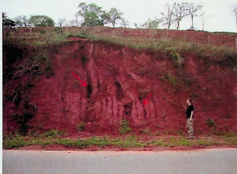
Fig. 24.1 – Vista geral do talude, com indicação de feições erosivas no material escorregado.
