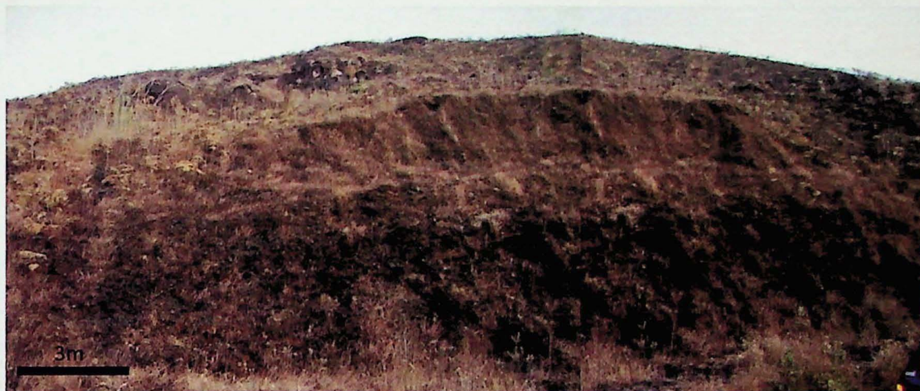
Fig. 1.1 – Talude de corte em colúvio encimado por encosta natural com blocos.
